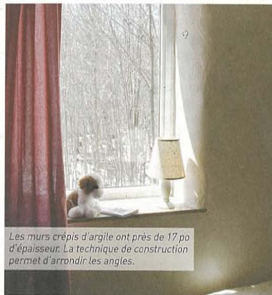
Les murs crépis d'argile ont près de 17 po d'épaisseur. La technique de construction permet d'arrondir les angles.
